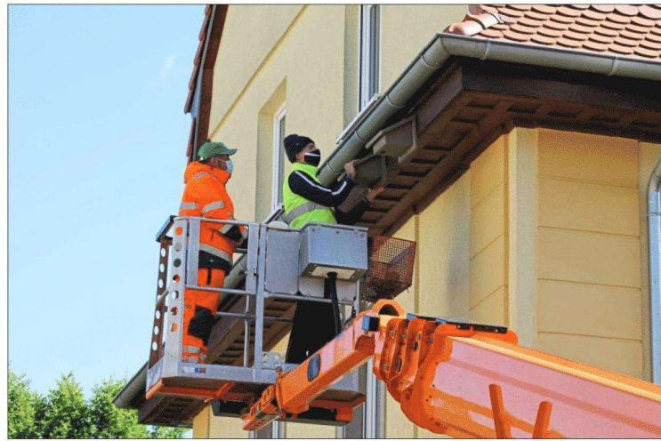
In luftiger Höhe: Kevin Fingermann (rechts) bringt mit Hilfe eines Mitarbeiters der Technischen Betriebe Rastatt Nistkästen für Mauersegler und Mehlschwalben an einem Wohnhaus in der Sibyllenstraße an. Foto: Holbein
