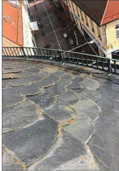
KLEINERE SCHIEFERPLATTEN kommen auf das Dach der Kirche St. Alexander.
