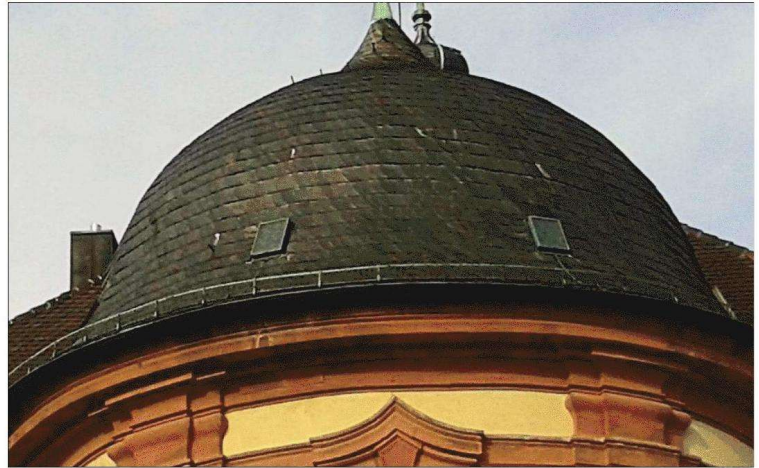
NEU EINGEDECKT wird das Chordach der Stadtkirche St. Alexander in Rastatt nach einem Wasserschaden. Das Material hat darunter gelitten, die Platten sind am Ende ihrer Lebenszeit. Fotos: Bäuerle
